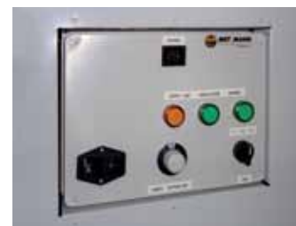
CUADRO ELÉCTRICO CON REGULADOR DE VELOCIDAD PARA EL EXTRACTOR DE HUMOS.
